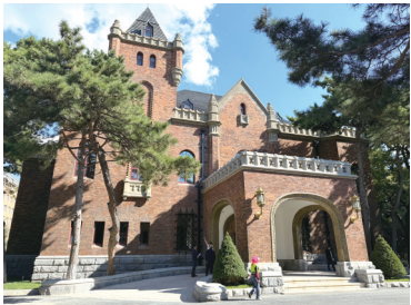
修缮后的建筑修旧如旧
