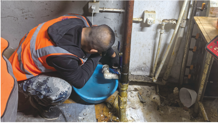
工人上门维修 社区供图
