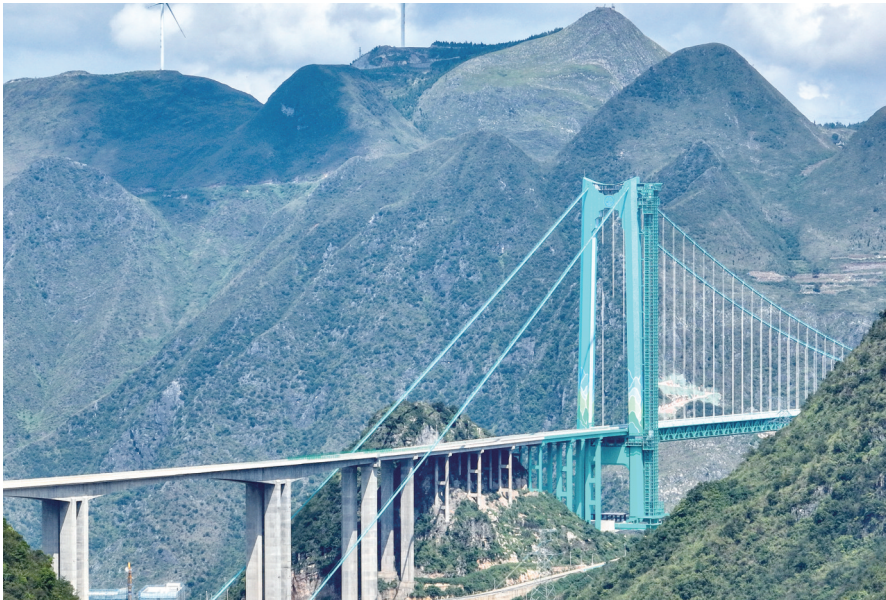
9月28日拍摄的贵州花江峡谷大桥(无人机照片)。新华社记者 欧东衢 摄 地势险峻。同时,气候多变、气象复杂,瞬时风力最高可达强台风级别14级,别说施工,人站在地面上都可能被风刮走。
