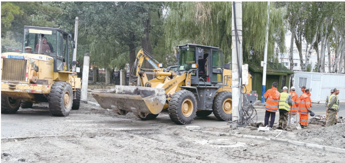
大型机械正在现场施工 城市晚报全媒体记者 刘佳雪 摄
