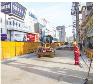
现场施工中 城市晚报全媒体记者 陆续 摄
