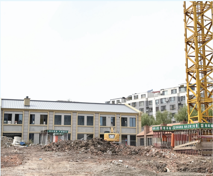
改造施工正在进行
