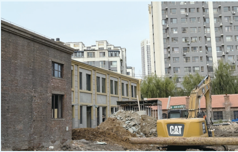
项目施工现场
