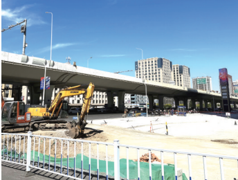
施工场地完成“退围还路”
