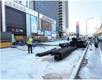
施工人员正在忙碌
