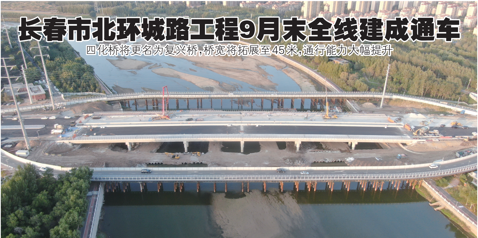
工程全面进入冲刺阶段 长春市建委供图
