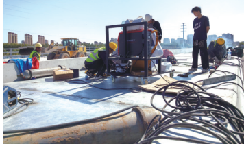
工人正在加班加点施工 城市晚报全媒体记者 陆续 摄
