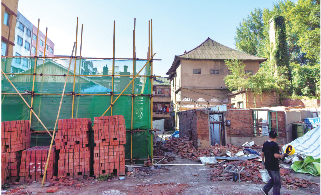
地块周边已设置了围挡 本组图片 城市晚报全媒体记者 陆续 摄
