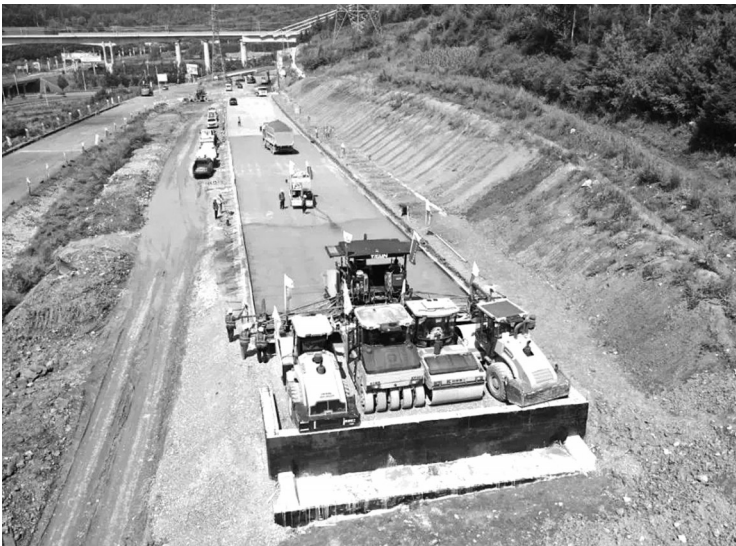
水稳试验段顺利摊铺 吉高集团供图 建成通车。 城市晚报全媒体记者 刘佳雪
