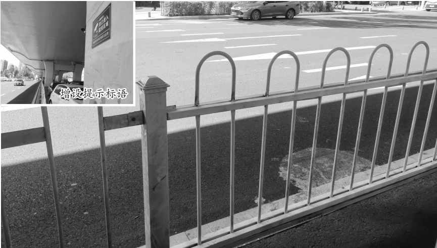
护栏已经修复 本组图片 城市晚报全媒体记者 吕闯 摄
