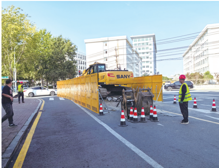
现场正在紧张有序地进行作业 城市晚报全媒体记者 陆续 摄 低对居民生活和交通的影响。一方面,合理安排施工时间,尽量避免在居民休息时间进行高噪音作业;另一方面,加强与交通管理部门的协作,优化周边交通疏导方案,确保道路基本通行。同时,施工方也承诺将全力以赴,在保证工程质量的前提下,争取早日完工,让居民早日受益于新的供暖设施,“预计再过一两天,施工任务就能够完成!” 此次供暖管道改造工程是长春市今冬供暖保障工作的重要组成部分。随着冬季的临近,长春市将持续推进各项供暖准备工作,确保广大市民能够温暖过冬。本报提醒广大市民,经过此路段时要注意避让或绕行。 城市晚报全媒体记者 陆续
