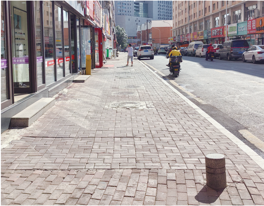
步行道的方砖已经修复 本组图片 城市晚报全媒体记者 陆续 实习生 孙之尧 摄
