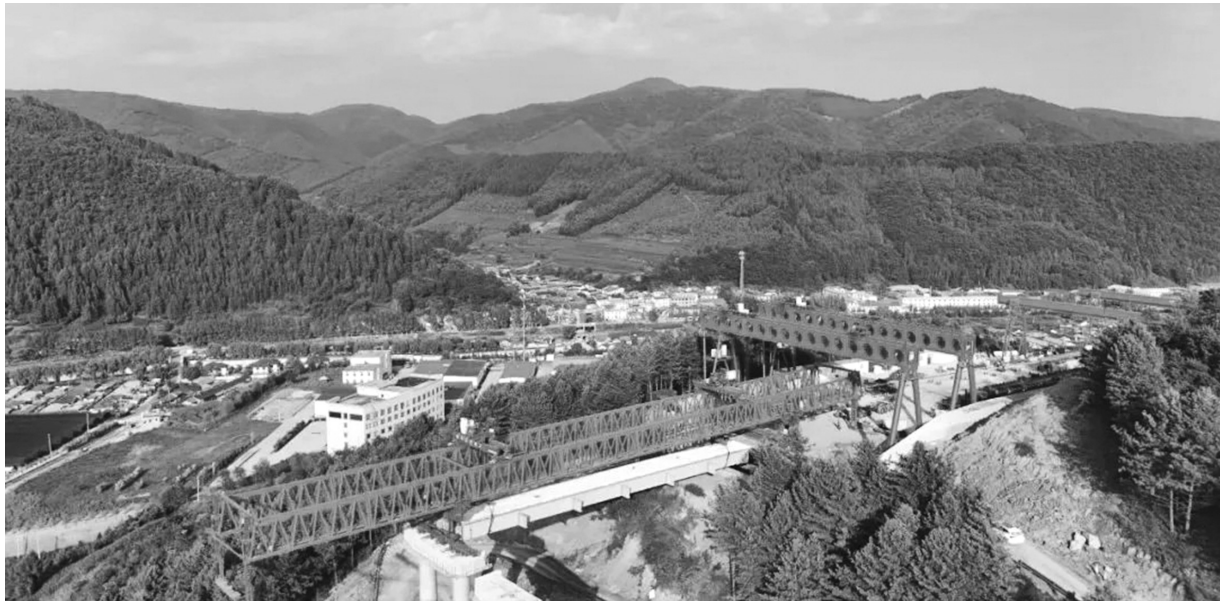
钢混组合梁成功架设 吉高集团供图
