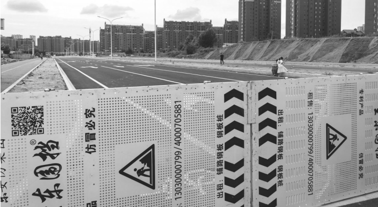
新建道路已基本完成 城市晚报全媒体记者 陆续 实习生 孙之尧 摄
