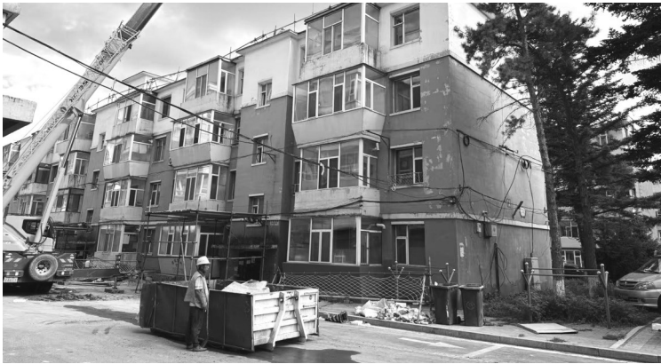
房顶防水施工 城市晚报全媒体记者 刘佳雪 摄
