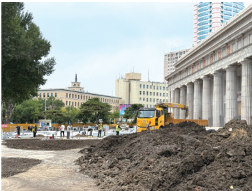
现场有人员和机械施工
