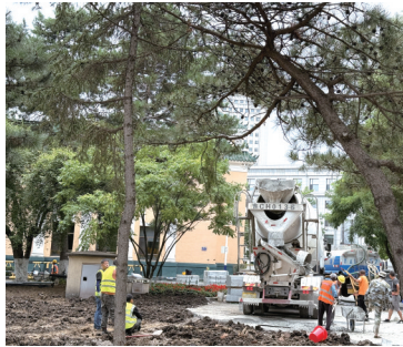
院落园路施工
