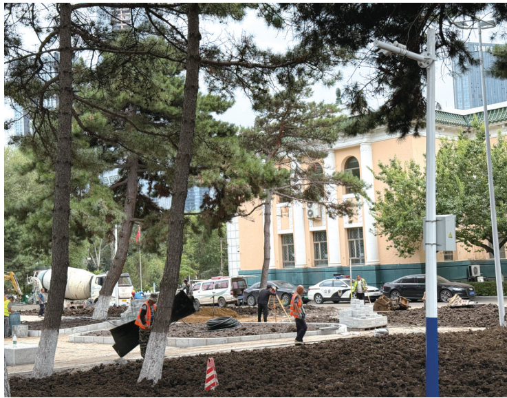
园林绿化施工
