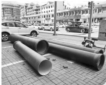
准备更换的雨水管线
