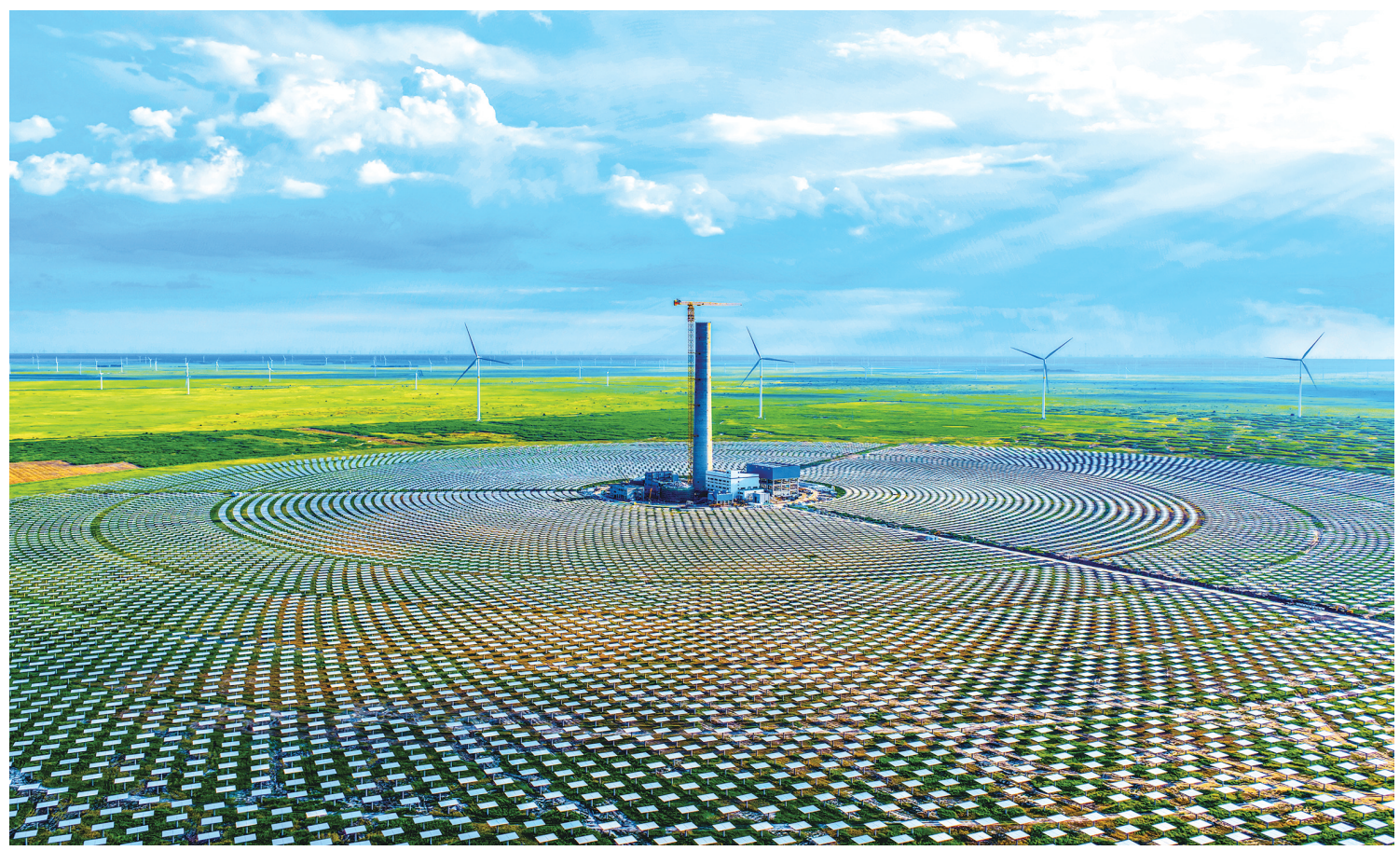
图为项目建设现场,一座“光棱塔”擎天而立,近2万面定日镜分布周围,场面壮观。记者 李晓明 摄
