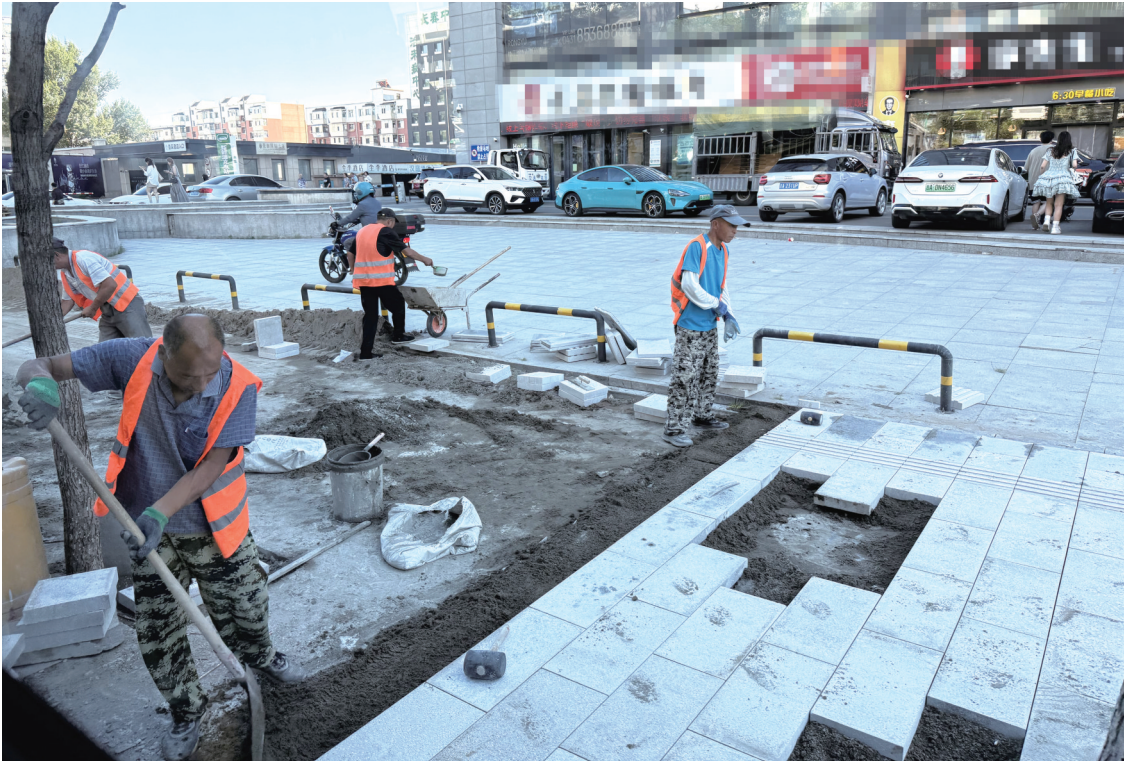
施工人员加紧推进 本组图片 城市晚报全媒体记者 刘佳雪 摄
