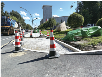
春城大街修复现场
