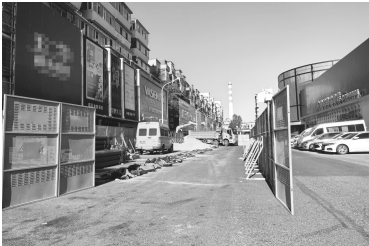
围挡圈出作业区 城市晚报全媒体记者 陆续 摄 近居民和路过市民能够加以理解!” 城市晚报全媒体记者 陆续 实习生 孙之尧
