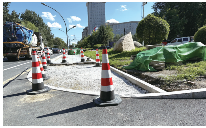
春城大街修复现场 城市晚报全媒体记者 刘佳雪 摄
