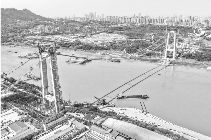
这是7月30日拍摄的重庆黄桷沱长江大桥主缆架设作业现场(无人机照片)。
