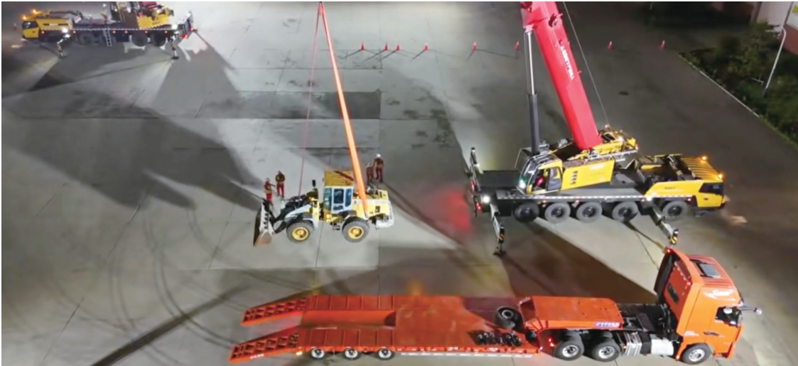
起重机械夜间吊装 本组图片 省交通应急中心供图
