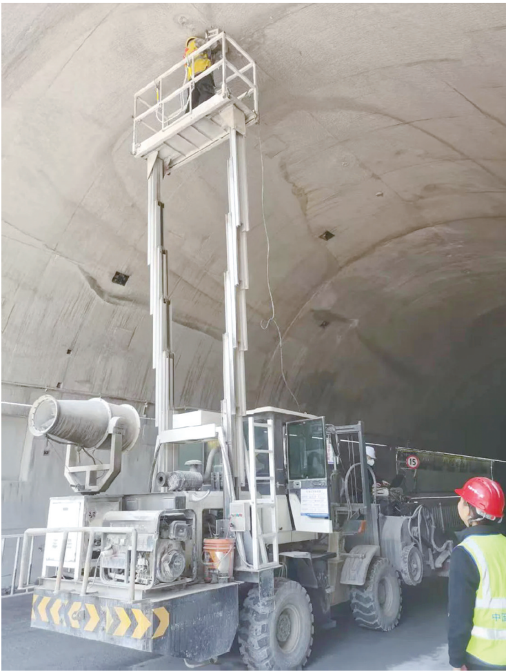
施工人员正在作业 本组图片 吉高集团供图
