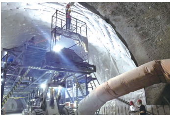
望天鹅隧道双幅贯通
