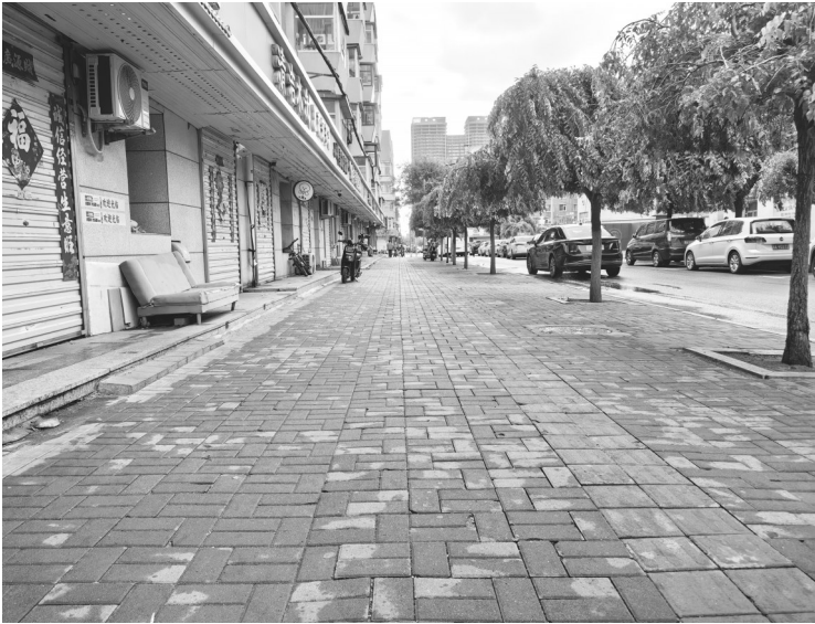
部分新铺设的平整的人行道 本组图片 城市晚报全媒体记者 陆续 摄
