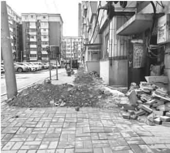
正在进行改造的人行道
