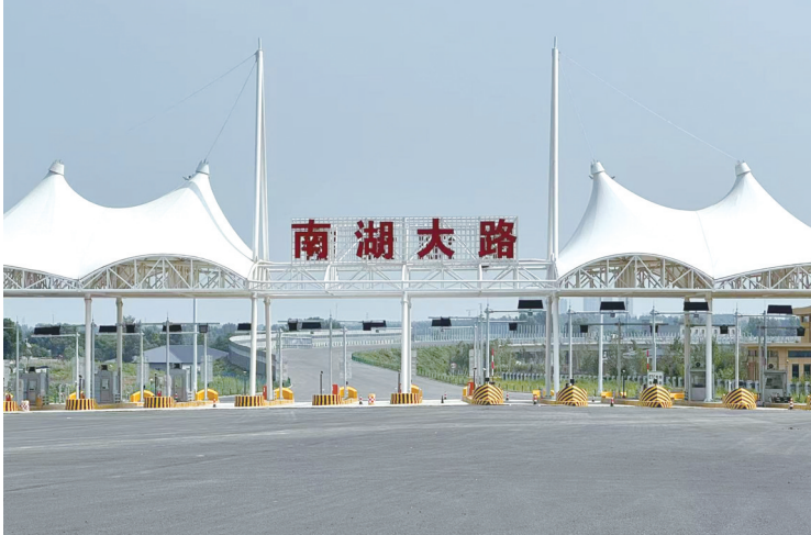
项目整体建设进度良好 本组图片 城市晚报全媒体记者 陆续 摄
