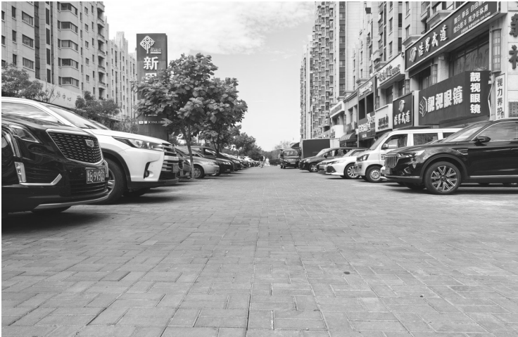
商铺门口的方砖已经全部修复完成 本组图片 城市晚报全媒体记者 陆续 摄
