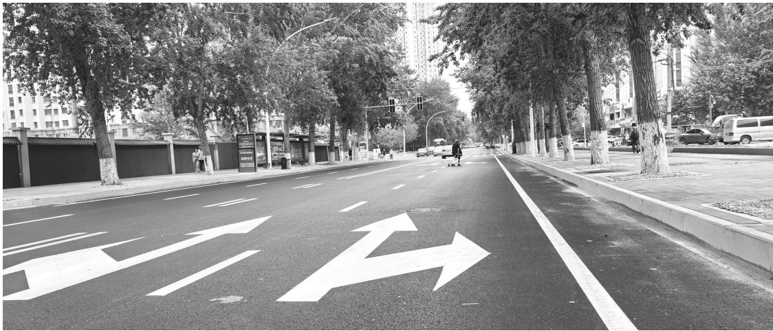
维修工程已经竣工并通车 城市晚报全媒体记者 陆续 摄
