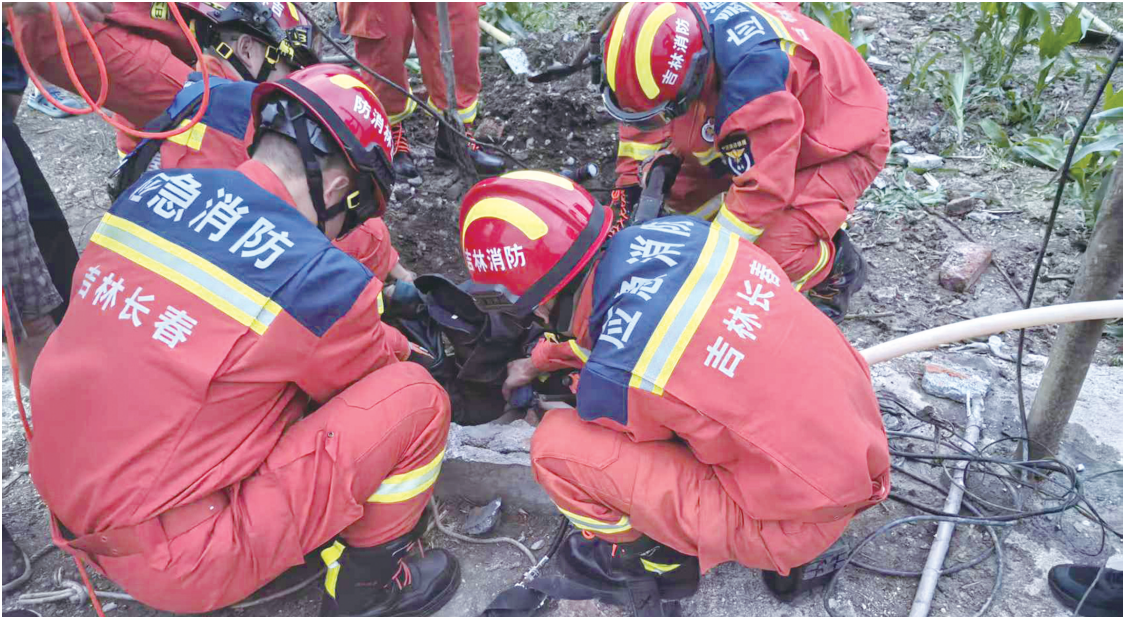
对井口周边进行破拆 消防供图
