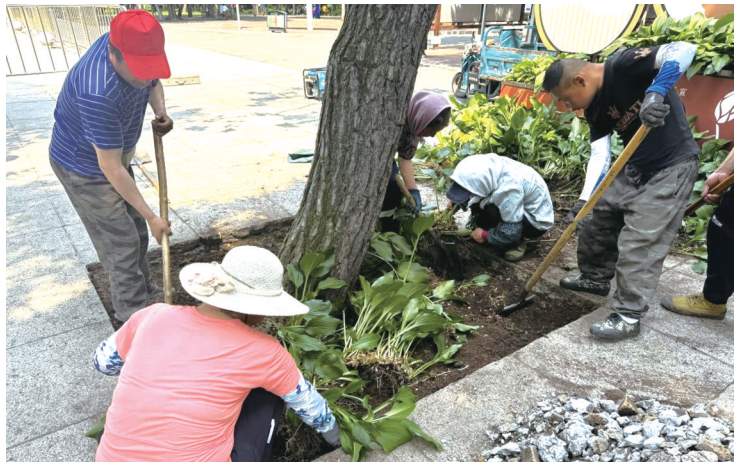
专业团队清除树穴中的混凝土 公园供图
