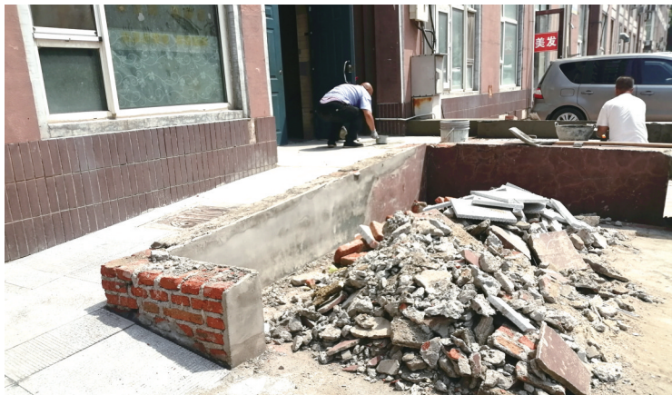
单元门改造坡道
