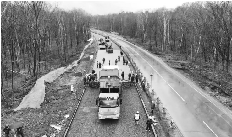
大型机械正在施工作业 省交通运输厅供图
