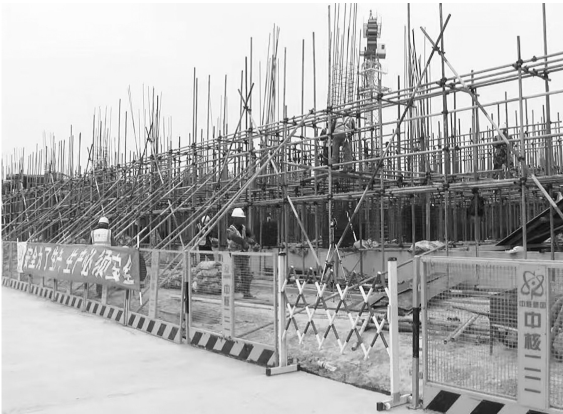
通榆县能源投资有限公司投资建设的鹤翔供热有限公司供热设施更新改造项目一期工程,预计今年10月竣工。据了解,该工程建成后,将满足通榆县中心城区近期361.89万平方米和远期822.89万平方米供热面积的供热需求,集中解决供热能源浪费等问题。图为近日,记者拍到的更新改造项目一期工程施工现场。 记者 张皓宇 张晓龙 摄
