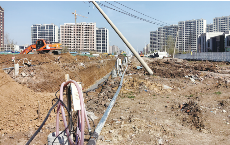
菜市北街“断头路”施工现场 城市晚报全媒体记者 陆续 摄
