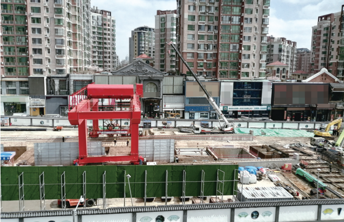
5号线湖西路站加紧施工 城市晚报全媒体记者 刘佳雪 摄
