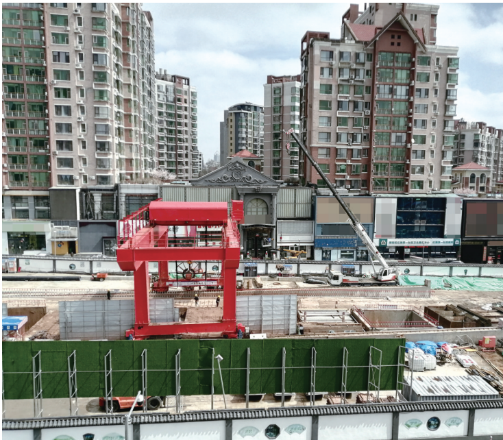
5号线湖西路站加紧施工 本组图片 城市晚报全媒体记者 刘佳雪 摄
