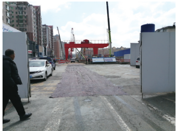
5号线湖西路站施工现场
