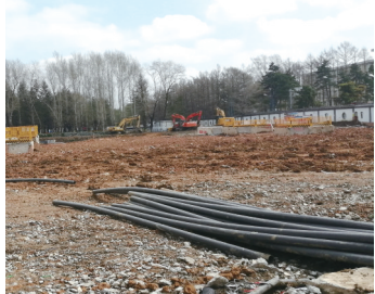
7号线南湖广场站建设工地
