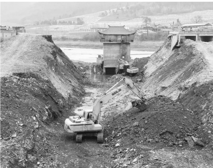
苇沙河大坝修复工程施工中 白山市公路处供图
