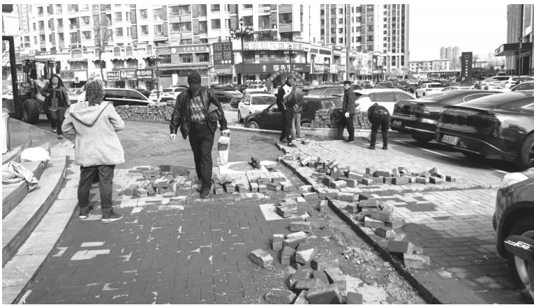
工人对路面进行修复和重新铺设方砖 城市晚报全媒体记者 陆续 摄
