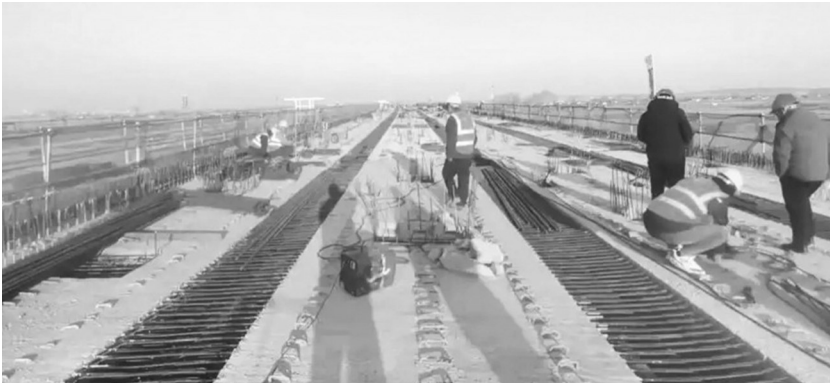
建设者们正在忙碌中 吉高集团供图
