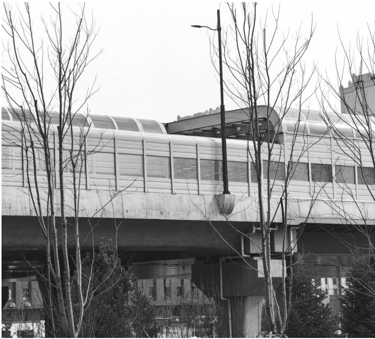
高架桥入口处没有安装全棚式声屏障 城市晚报全媒体记者 陆续 摄
