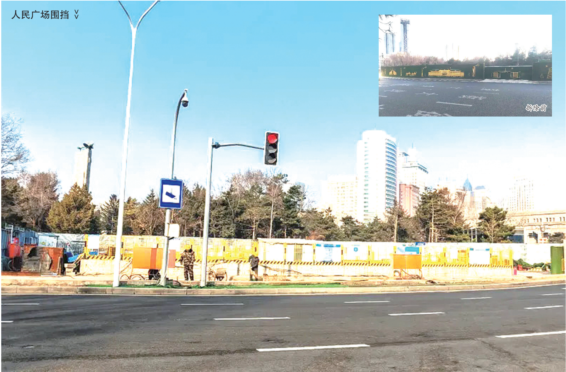
拆除后 本版图片 长春轨道交通集团供图
