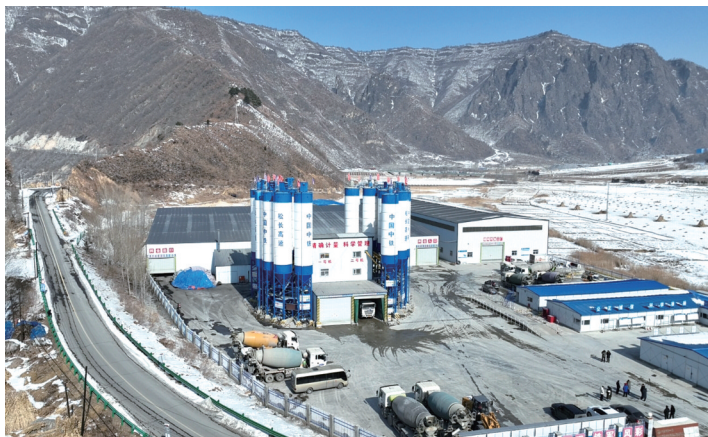
施工现场 省公路局供图
