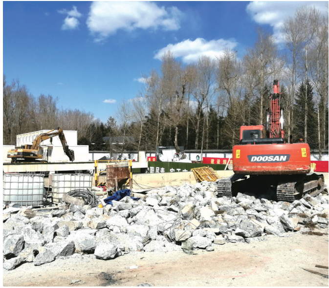
拆除硬化路面
