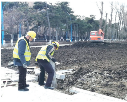
工人正在施工
