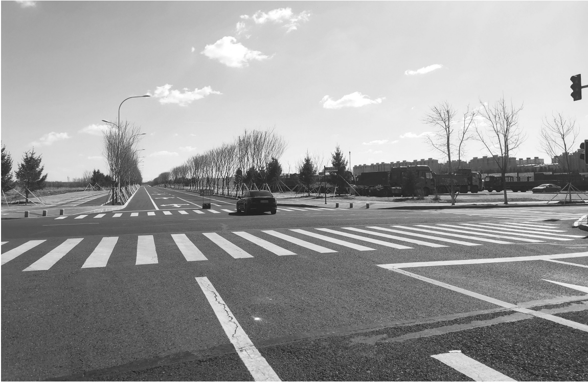
明溪路东延道路已完成 本组图片 城市晚报全媒体记者 吕闯 摄
