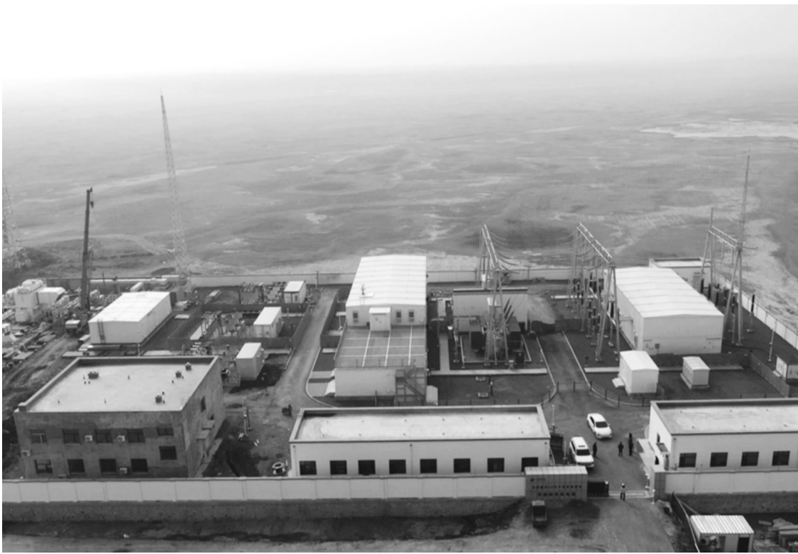
近日,华能通榆长龙山20万千瓦风电项目现场一派繁忙景象。据了解,截至目前项目已完成31.5千米场区道路全线贯通;266基铁塔基础、32台风机吊装全部完成;升压站完成且正在调试。预计4月初并网发电。该项目建成后预计每年可为电网提供清洁电能约5.5亿千瓦时,减少二氧化碳排放约53万吨。
