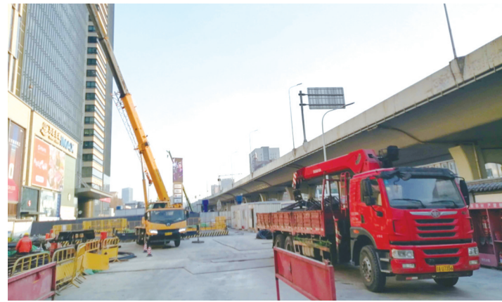
轨道交通5号线繁荣路西站点施工 城市晚报全媒体记者 刘佳雪 摄
