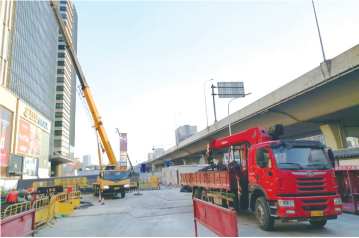
轨道交通5号线繁荣路西站点施工
