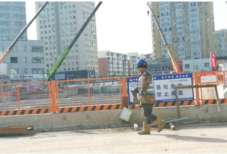
一名施工人在5号线同志街站工地
