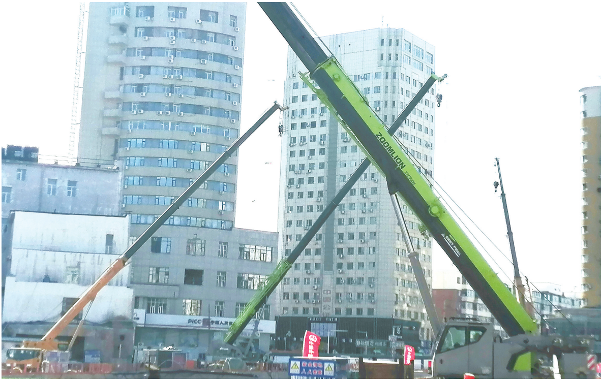
轨道交通5号线同志街站建筑工地 本组图片 城市晚报全媒体记者 刘佳雪 摄
