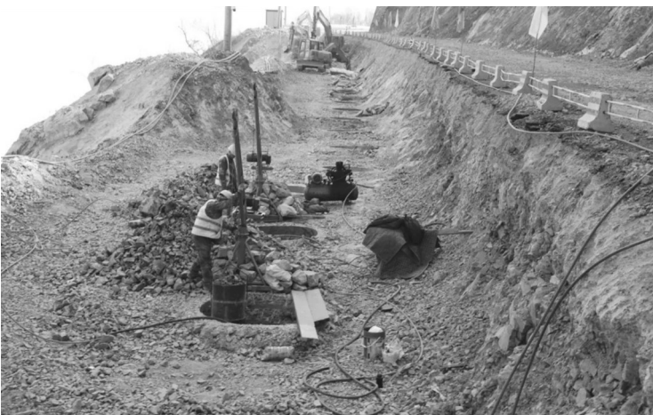
施工人员现场作业 白山市交通运输局供图
