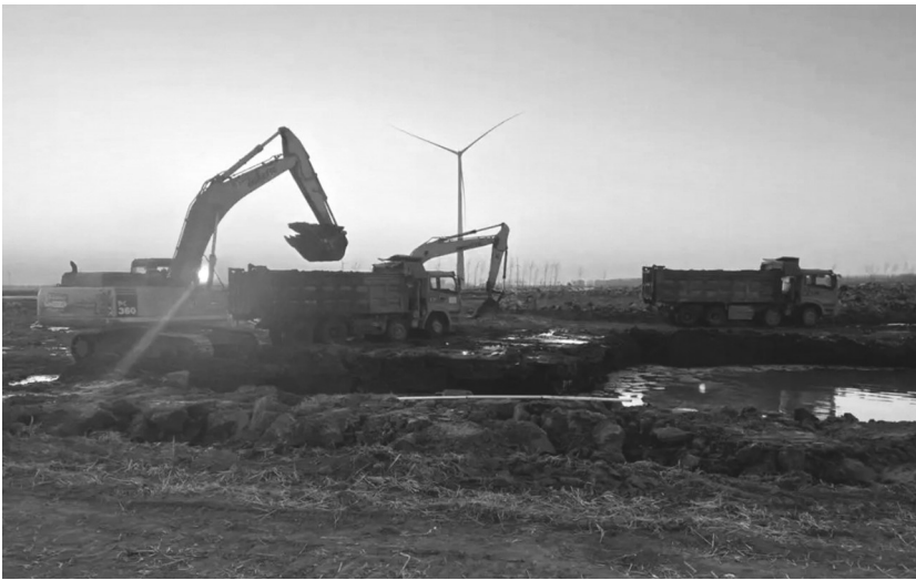
现场运输车辆正在施工 省交通宣传中心供图
