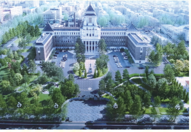
吉大基础医学院(伪满国务院旧址)
