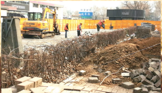
工人开挖探坑
